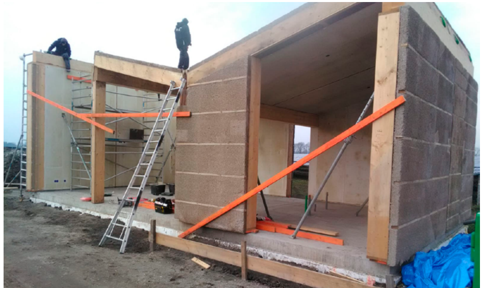
LESRUIMTE IN AANBOUW
